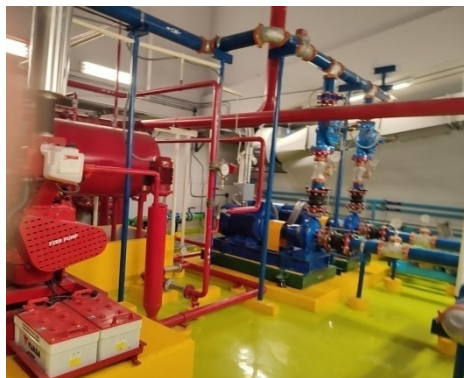
ภาพที่ 3-18 เครื่องสูบน้ำดับเพลิง
