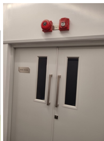
ภาพที่ 3-16 ห้องหม้อแปลงไฟฟ้าติดตั้งอุปกรณ์แจ้งเหตุเพลิงไหม้และอุปกรณ์ดับเพลิง
